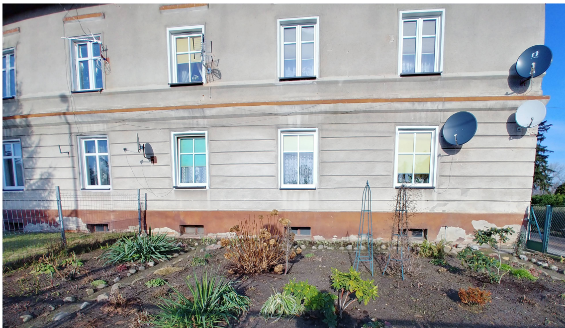
Gryfice, ul. Broniszewska 17 ogródki mieszkańców od frontu budynku
