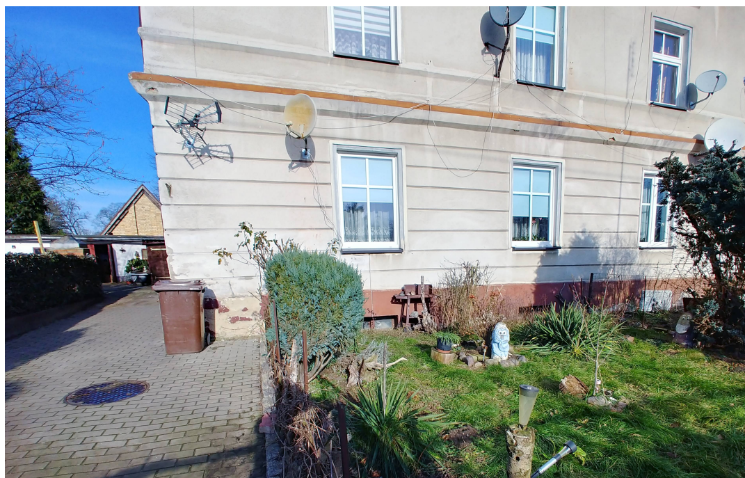
Gryfice, ul. Broniszewska 17 istniejące utwardzenie terenu z kostki betonowej, liczne nasadzenia przy ścianach budynku
