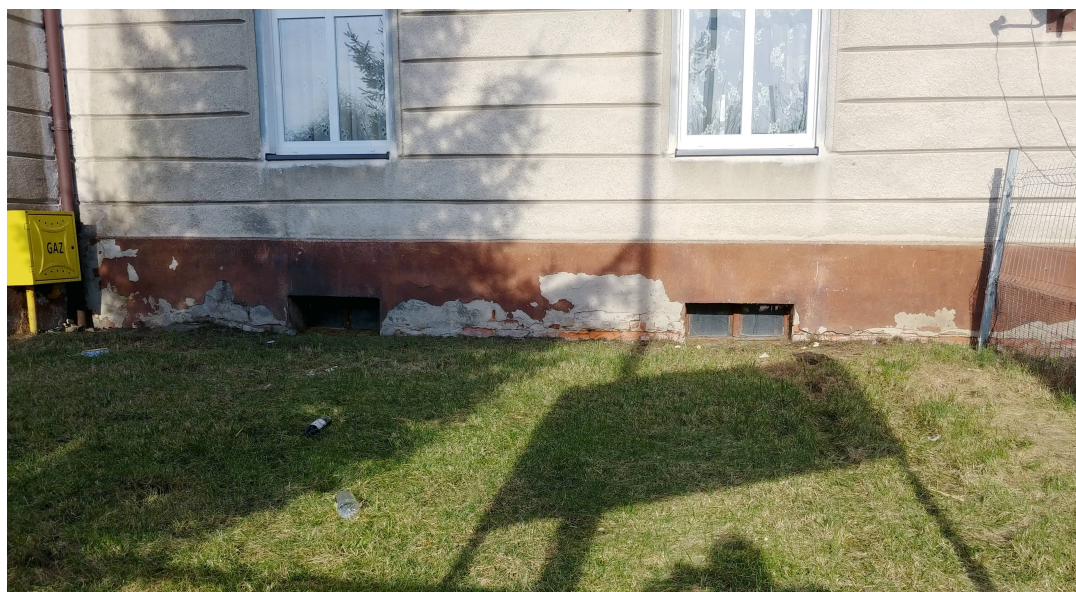
Gryfice, ul. Broniszewska 17 silne zawilgocenia ścian cokołu
